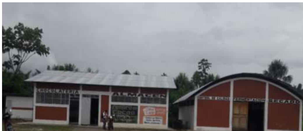
Figura 3: Área de infraestructura de elaboración de cobertura bitter de copoazú.
