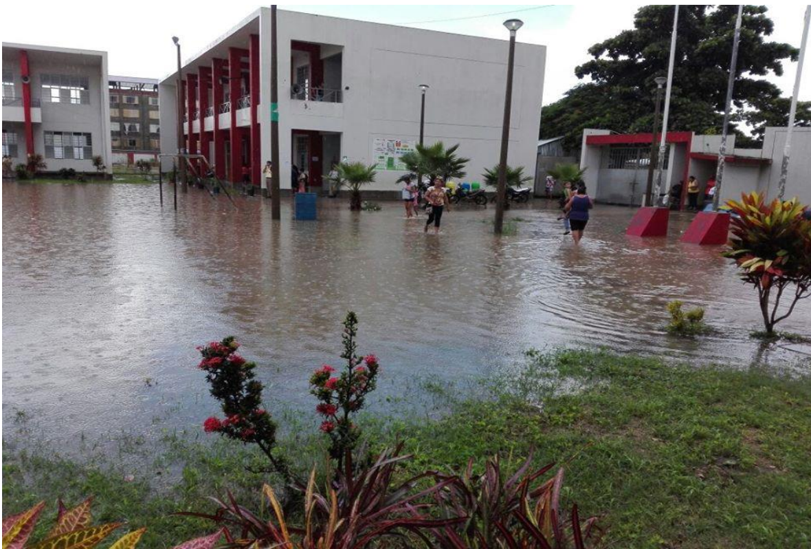
IMAGENES TOMADA EN NOVIEMBRE DEL 2017 EN EL INTERIOR DEL COLEGIO CARLOS FERMIN FITZCARRALD QUE MUESTRA SUS AMBIENTES INUNDADOS.
