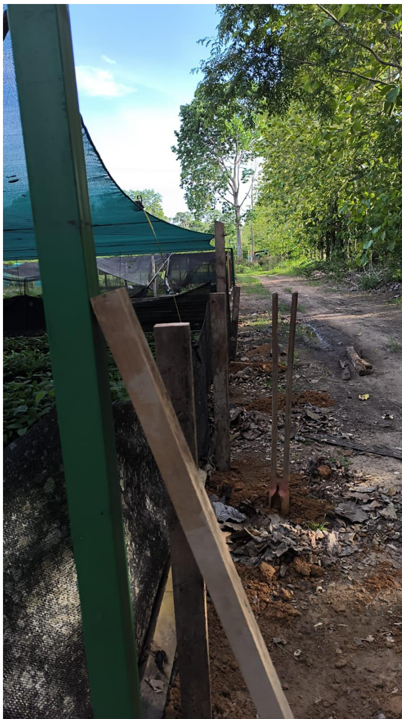
Figura 60. Excavación en el exterior del vivero para colocar los listones.
