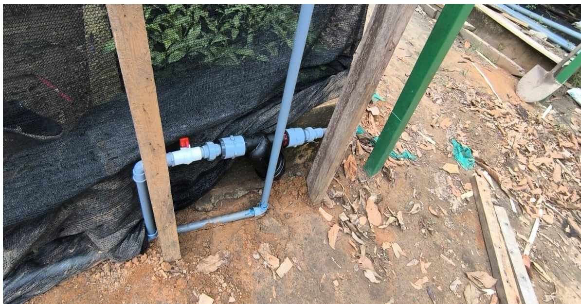
Figura 27. Instalación de electroválvula.
