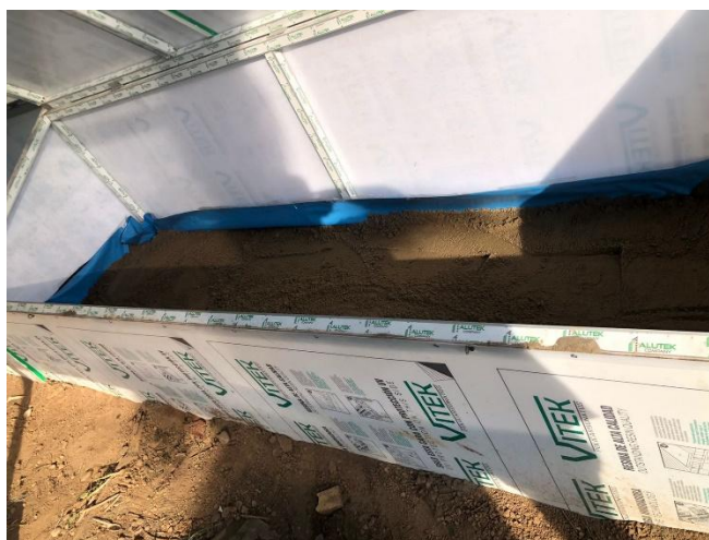
Figura 7. Instalación y agregado del sustrato de arena a las camara de subirrigacion
