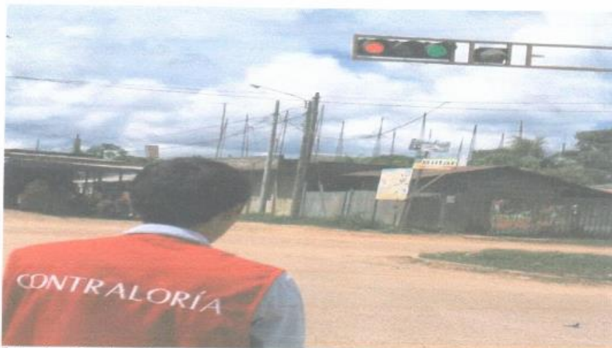
Fotografía n.º 9: Jr. Jorge Chávez con Av. Circunvalación semáforo malogrado (luz verde y rojo alumbran a vez). Elaborado por: Equipo de Orientación de Oficio.
