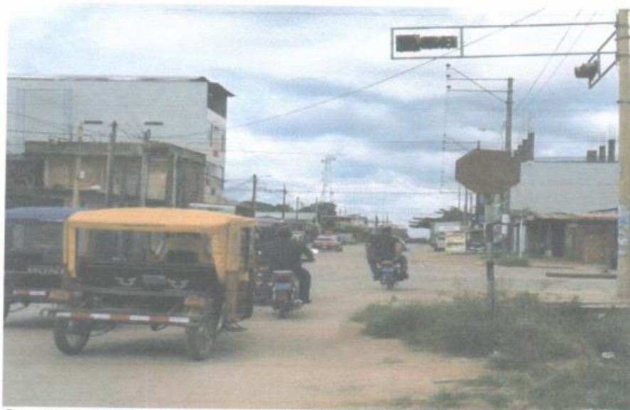
Fotografía n.º 10: Jr. Junín con Av. Tambopata semáforo malogrado (luz verde deficiente). Elaborado por: Equipo de Orientación de Oficio.
