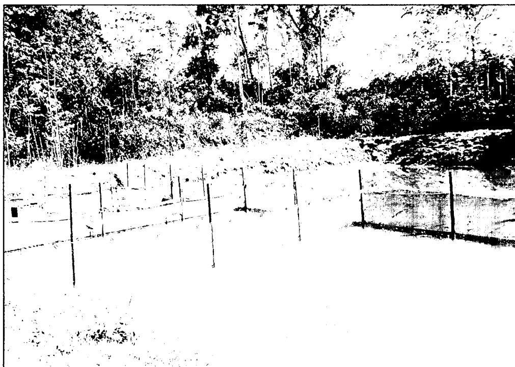
Figura 07. Acondicionamiento y construcción de Corrales Experimentales.
