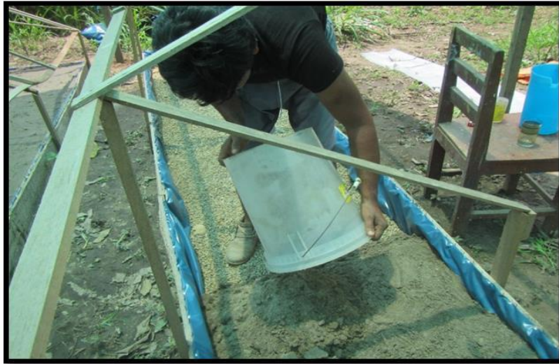
Fotografía 29: Llenado de arena de forma uniforme encima de la capa de piedras que se encuentra en la parte inferior de la cámara de propagación vegetativa
