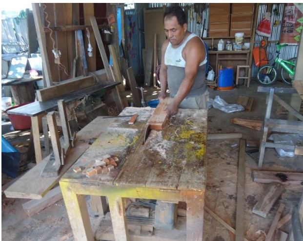
Foto 13: Proceso de perfilación de las viguetas.
