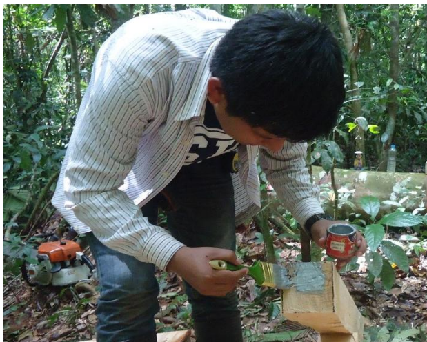
Foto 11: Tratamiento en los extremos de las viguetas con pintura de aluminio.
