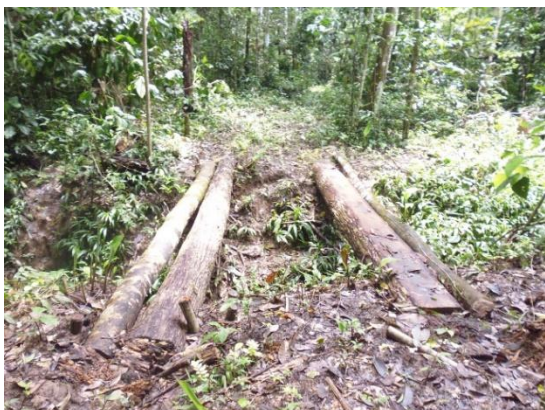
Fotografía 15. Puente en área intervenida
