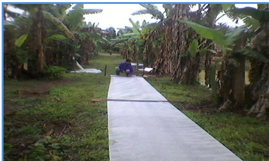
Figura 7: Extendido de mallas de fibra de plástico.
