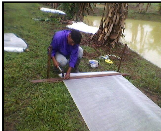
Figura 19. Clavado de la malla con estacas.
