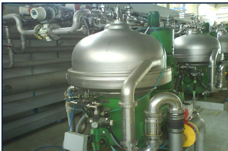
Figura 18: Centrifuga de aceite
