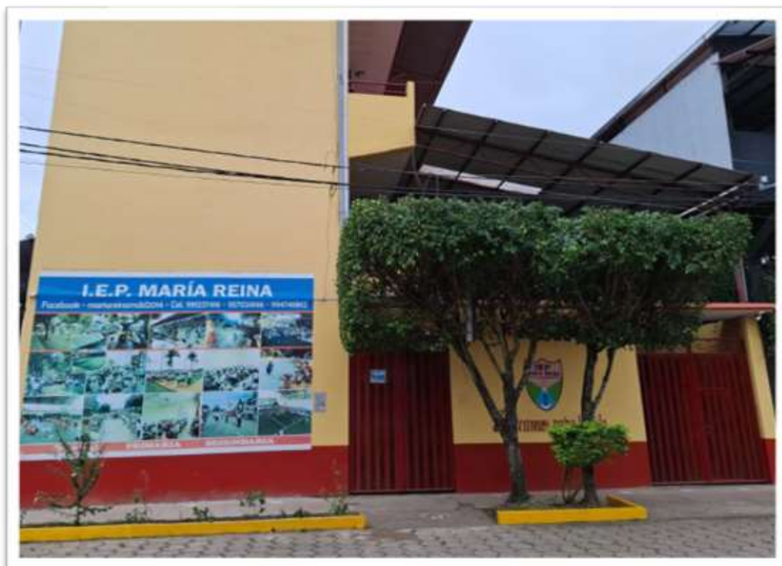
Anexo 10. Panel fotográfico.
