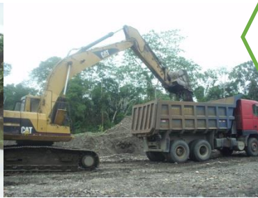
Procedimiento de remoción y traslado de material con maquinaria pesada
