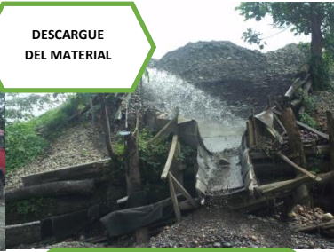
DESCARGUE DEL MATERIAL Procedimiento de lavado de material
