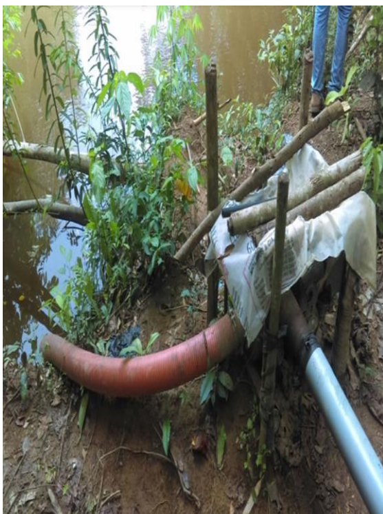
Figura 44. Captación de agua de manera informal del río.
