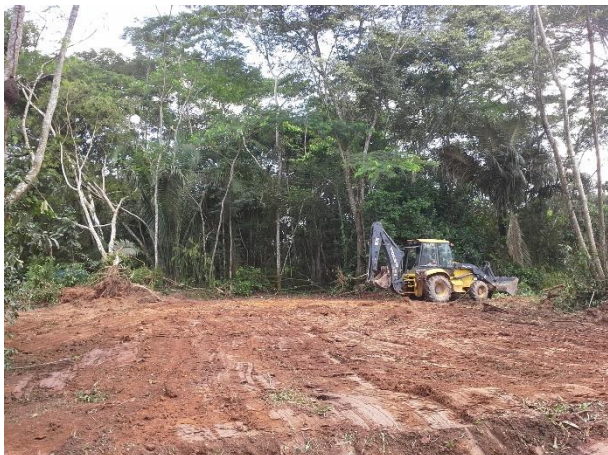
Foto 01: Limpieza del terreno para la implementación del sistema de biodigestión.
