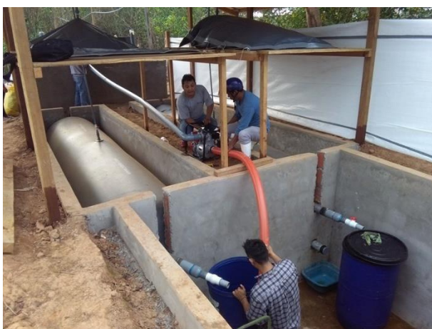
Foto 11: Montaje de Sistema de biodigestión en el centro frigorífico.
