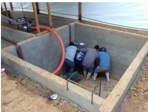
Foto 09: Colocación de tanques.
