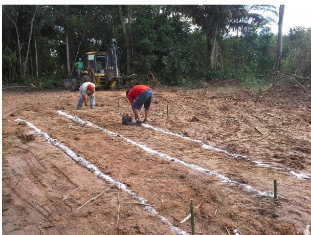
Foto 03: Mediciones de los lechos para el reactor de geomembrana.
