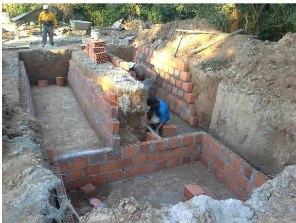
Foto 05: Construcción del sistema de biodigestión.
