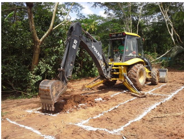
Foto 04: Excavaciones para la construcción de los lechos.
