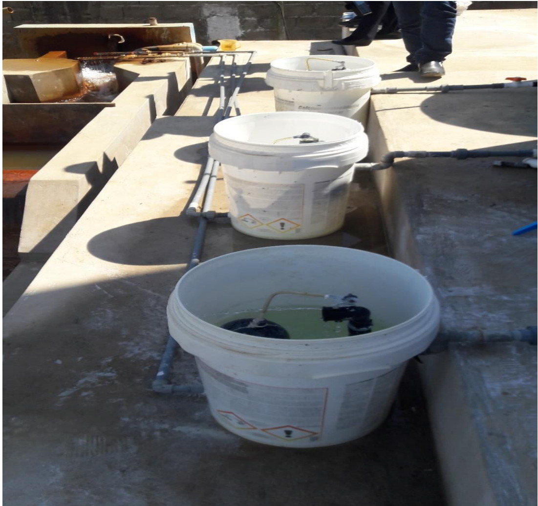
Foto 2: Proceso de tratamiento de agua - JASS El Triunfo
