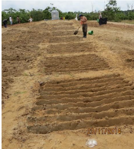
Fig 4. Preparación del terreno.
