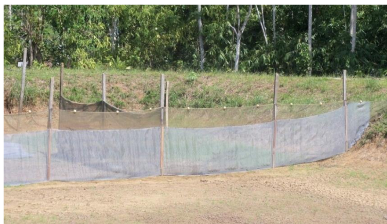
Figura 14: Ripas colocadas en cada estaca
