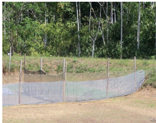
ANEXO 06. Reforzamiento de malla
