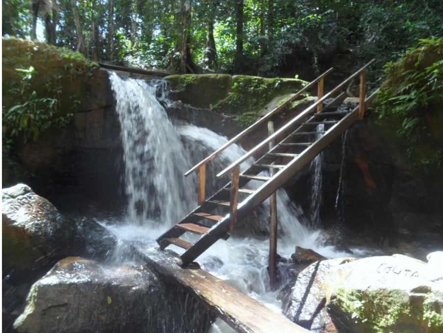
Foto 3. Infraestructura actual de la catarata Colpayoc.
